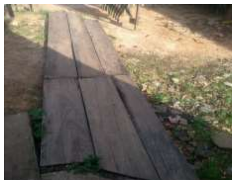
Figura 2 – Rampas improvisadas. Créditos: OLIVEIRA, 2019.
